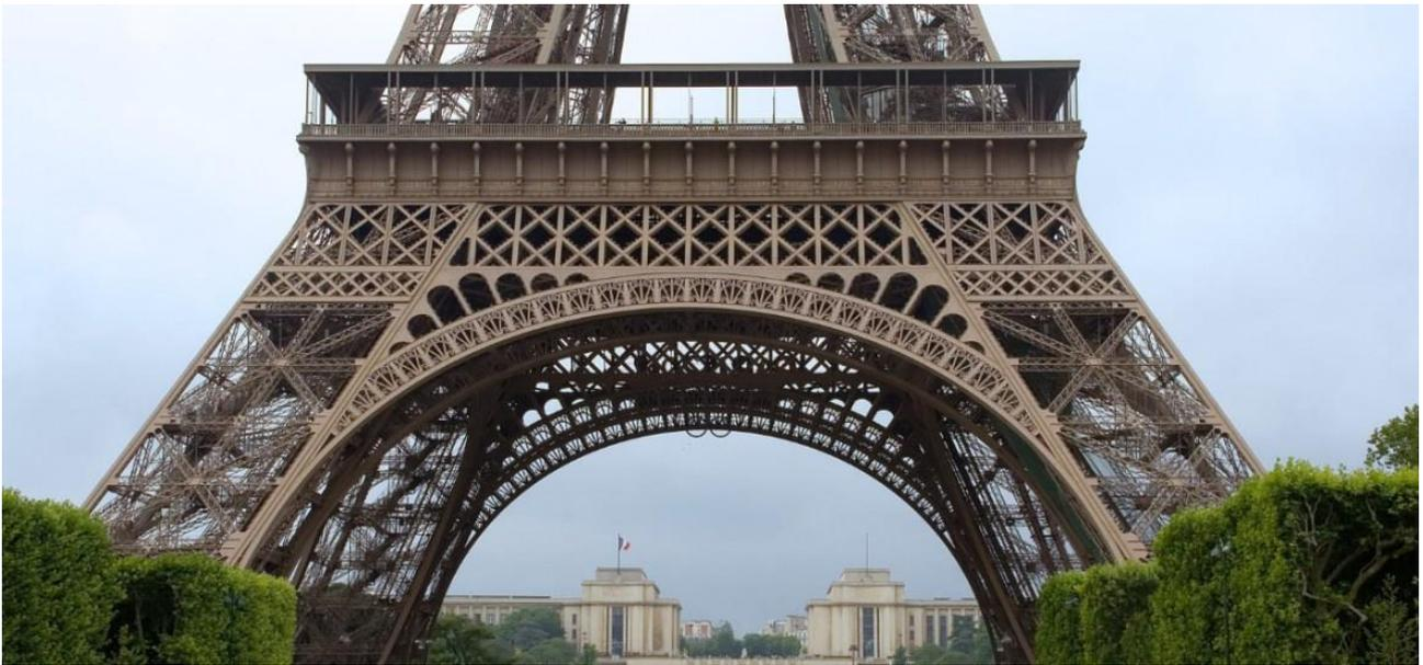
La segunda preocupación era evitar que la torre se deformara (o balanceara) en exceso a causa de la acción del viento, por lo que debía ser una estructura de elevada rigidez. Esto se consiguió mediante dos recursos: la conexión de los cuatro grandes pilares de la torre mediante una gran viga de celosía a la altura de la primera planta y el sistema de la triangulación.
