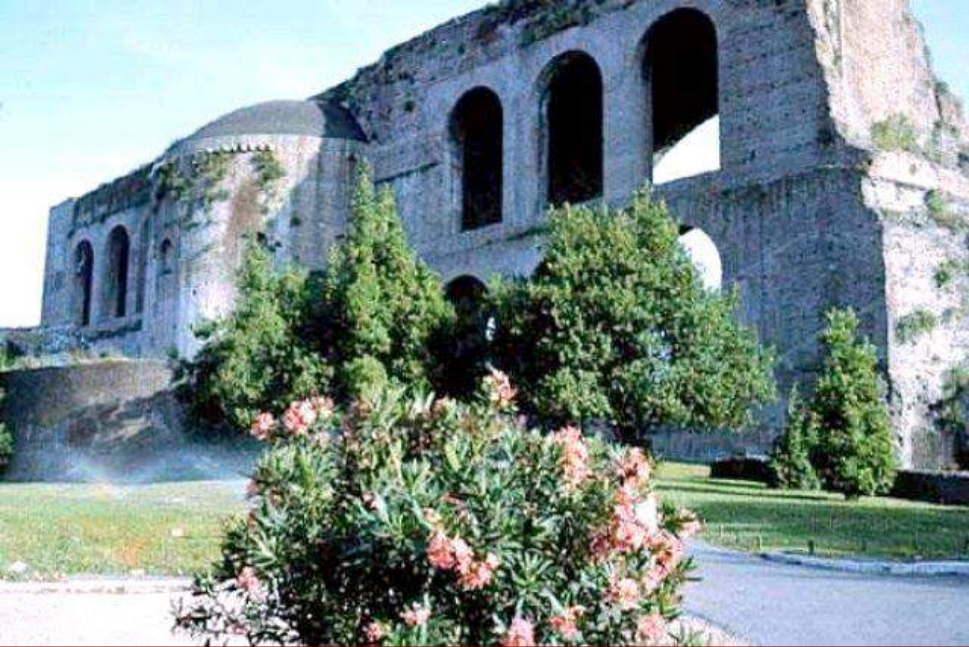
Ábside de la Basílica de Majencio
